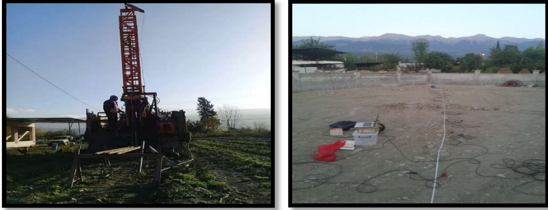
Foto-7: Zemin Etüt Çalışmalarından Bir Görünüm
